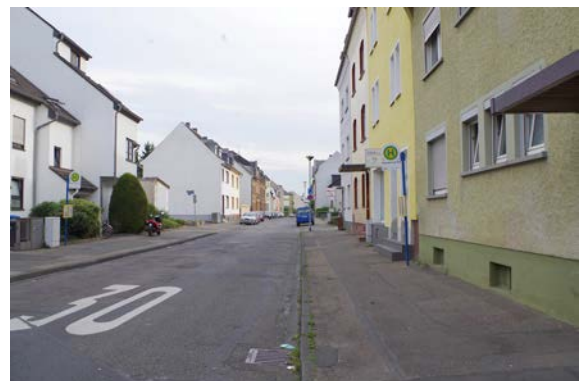
von oben: der Abwärtstrend wird durch den Sanierungstau an Gebäuden befördert; auch die Freiräume bedürfen einer Aufwertung und Neuordnung; Sanierungsbedarf im Plankenweg
