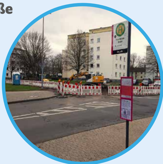
Beitrag von Tief-Bau-Amt und Johannes Kuhl, Stadt-Teil-Manager (Foto: Johannes Kuhl)
